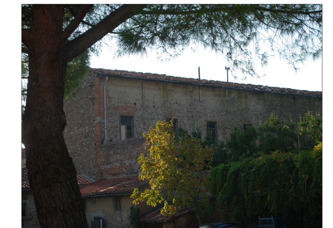
Copertura in oggetto dalla corte del centro di accoglienza
