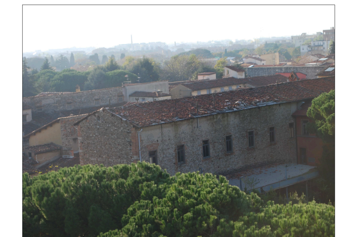
Vista dall'alto della copertura oggetto dell'intervento (falda prospiciente la corte interna)
