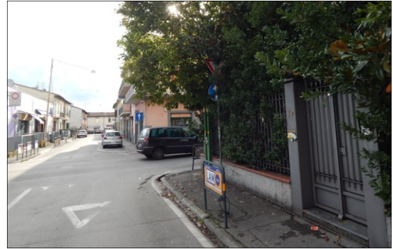
Incroccio Via F. Filzi – Via D. Chiesa: segnaletica verticale non visibile
