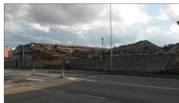
Via G Castagnoli – Via G. Monaco: Aree industriali inutilizzate e fatiscenti
